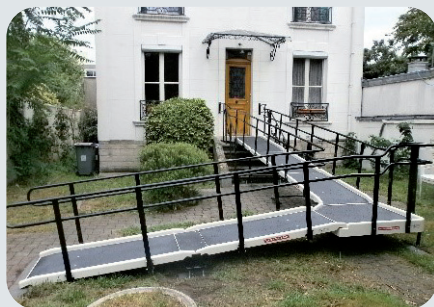
Rampe bâtiment pour PMR
